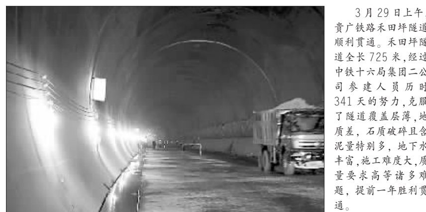
3月29日上午,贵广铁路禾田坪隧道顺利贯通。禾田坪隧道全长725米,经过中铁十六局集团二公司参建人员历时341天的努力,克服了隧道覆盖层薄,地质差,石质破碎且含泥量特别多,地下水丰富,施工难度大,质量要求高等诸多难题,提前一年胜利贯通。
