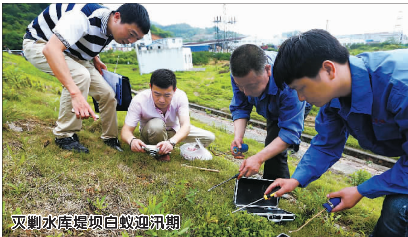
6月7日,在浙江省宁波市北仑区新碶街道香溪水库背水坡上,白蚁防治人员和水库管理人员在排查白蚁分飞点。眼下白蚁正进入繁殖出飞期,浙江省宁波市北仑区水利局联合白蚁防治站,对全区30座水库大坝展开白蚁灭剿工作,通过生物药剂点杀和诱杀包诱杀的方式灭剿堤坝白蚁,消除水库堤坝安全隐患,确保水库汛期安全运行。
