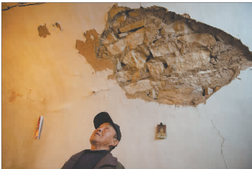
→78岁的贾相青所生活的榆林村毗邻煤炭产区,过去连年的炮采作业造成村里耕地及房屋不同程度的开裂及塌陷。
