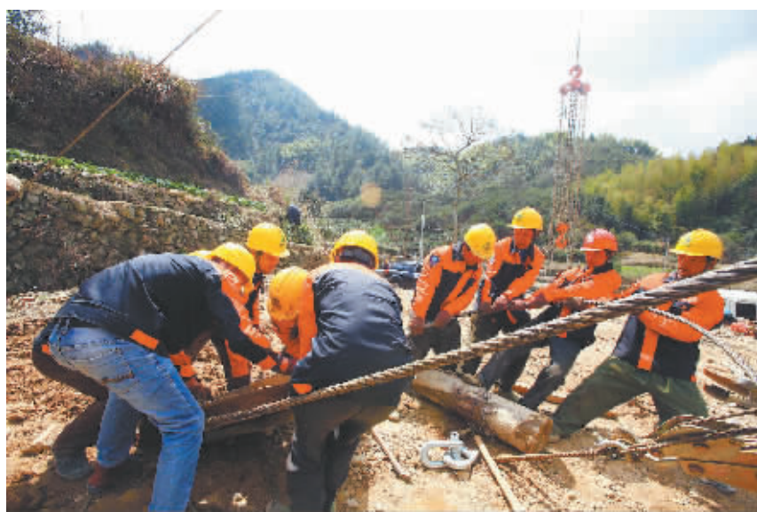
施工多在崇山峻岭,作业环境非常艰苦。图为员工在湖北-福州1000千伏特高压交流输电工程工地施工。
