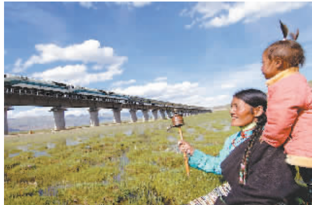
10年来，1956公里的青藏铁路成为“世界屋脊的钢铁大道”，架起了“世界屋脊”通向世界的“金桥”。 —— 梁果 摄
