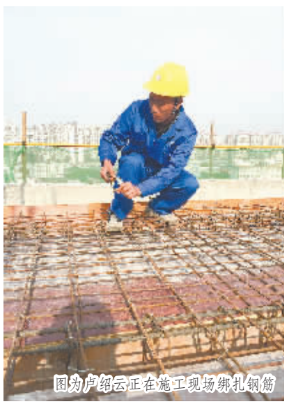
图为卢绍云正在施工现场绑扎钢筋
