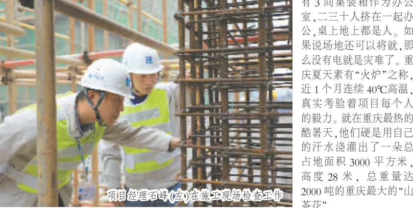
项目经理石峰(左)在施工现场检查工作
