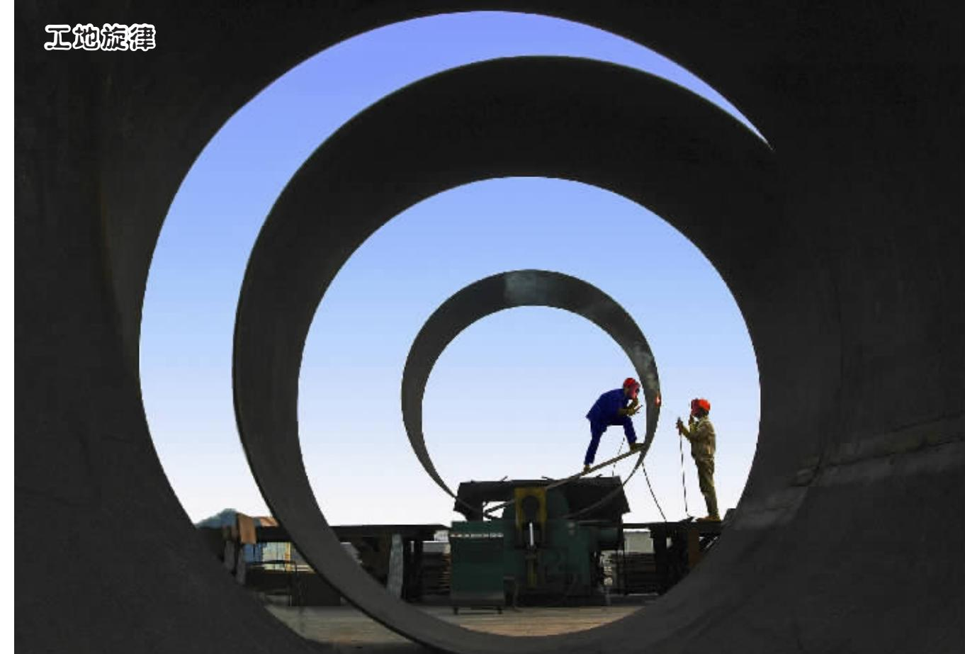
图为江苏泰州一建设工地上,工人们正在焊接高压导气管。
