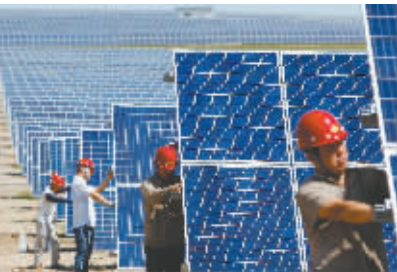
建设中的科右前旗光伏工程
