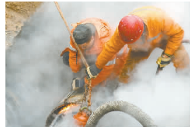
▲在北京市海淀区南路,抢修组的工人正在进行供热管道故障抢修。
