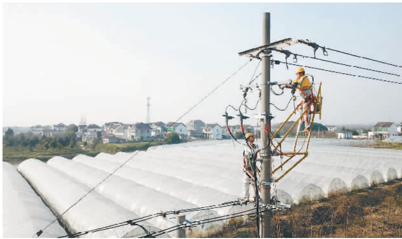
青浦公司首次采用绝缘平台作业法实施不停电作业
