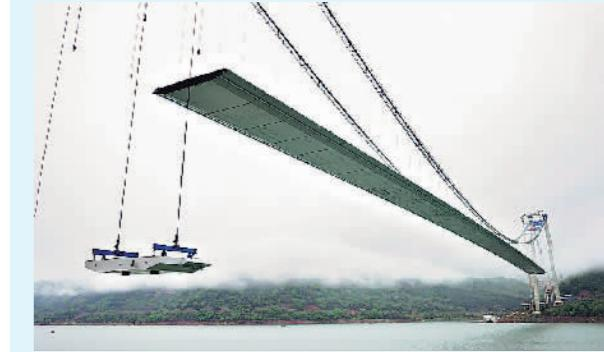
4月7日，重庆新田长江大桥南岸1号段完成钢箱梁吊装空中移荡72米的施工环节。碧波荡漾的长江水面上，220吨重钢箱梁在跨缆吊机的作用下稳稳起吊，在高空实现连续二次荡移，完成“空中接力”高难度技术动作，精准定位于桥面安装点。
