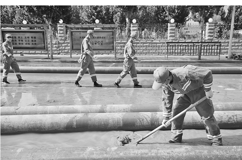
7月25日,郑州的一条马路上,消防队员正在进行清淤作业。
