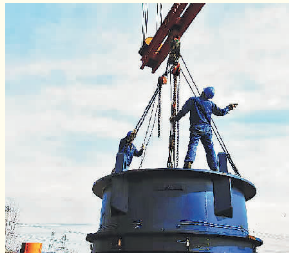
2020年9月,钳工班拍摄检修塔吊回转机构时的场景。
