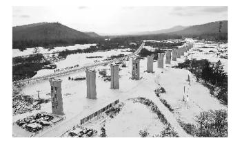
11月20日,国内在建最北高铁——哈(尔滨)伊(春)高铁 铁(力)至伊(春)段先行标施工现场,中铁二十二局建设者将 最后一方混凝土缓缓注入桩基,为国内首例高铁桥梁多年冻 土桩基施工画上了圆满的句号。该先行标是哈伊高铁的重要 组成部分,全长60.28公里,位于高纬度高寒地区,全年最低气 温达零下39.7摄氏度,有4个月平均气温在零摄氏度以下。
