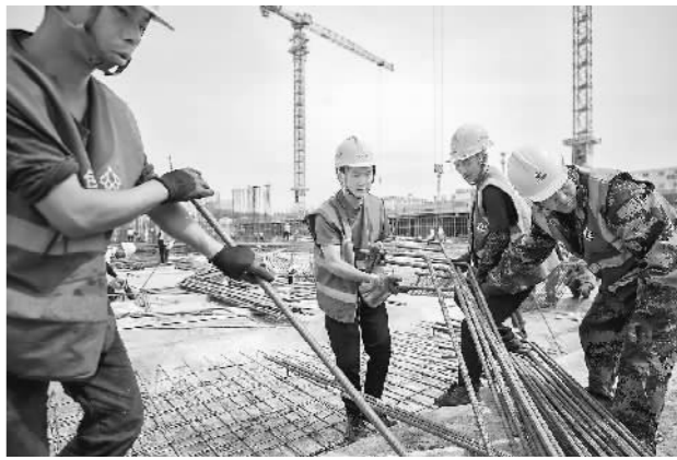
2021年5月9日,河北雄安新区容西片区建设现场,建设者正在搬运钢筋。 本报记者 王伟伟 摄
