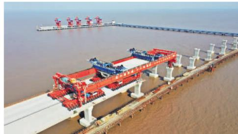
近日,中铁十六局集团杭甬复线宁波一期S1标项目建设者,驾驶我国自主研发的目前世界上最大的公路架桥机,将一片重达1800吨的50米整孔预制箱梁架设在滨海高架桥上。
