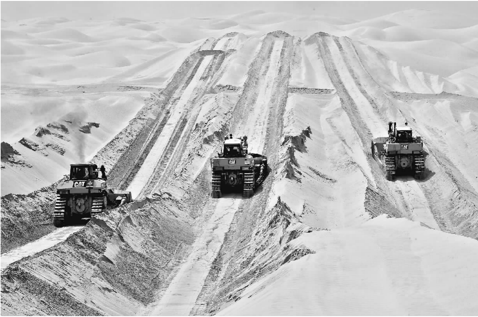
在沙漠中修路,首先要推平一座又一座沙山。
