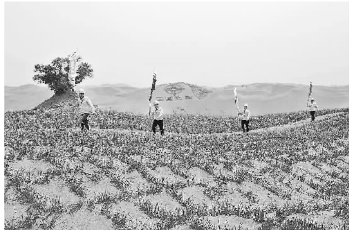
用于防沙固沙的草方格,需要全部由手工完成。
