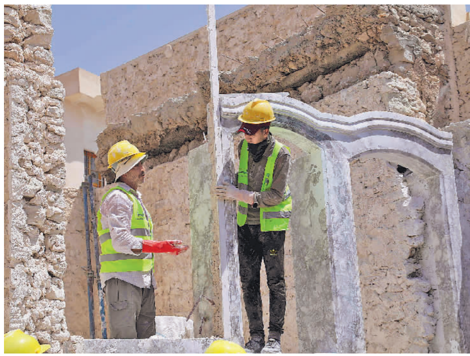
7月3日,工人在伊拉克摩苏尔老城修复受损房屋。
