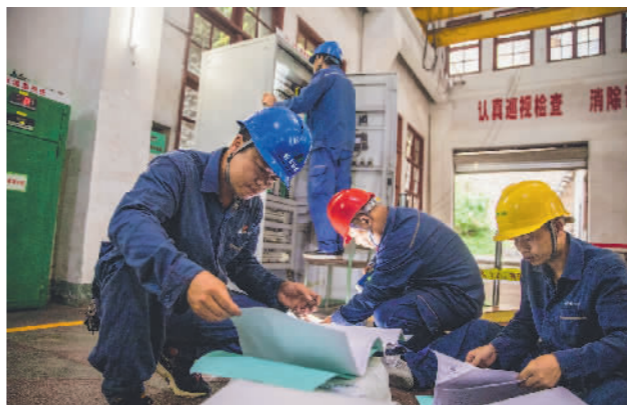
7月17日,龙安勇(左一)正在水电站的机房内检修设备。
