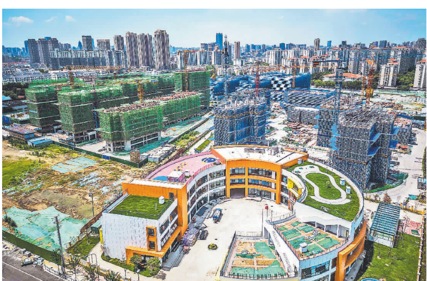
8月3日拍摄的正在改造的安徽省合肥市瑶海区龚大塘城中村改造项目(无人机照片)。
