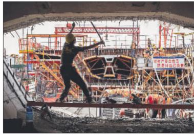
2022年7月19日,在中山市马鞍岛智慧梁场,建设者们正在制作每节长约60米、重达2752吨的深中通道混凝土箱梁。
