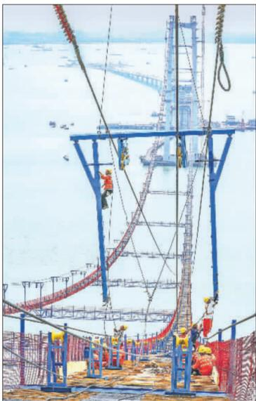
2022年4月30日,深中通道伶仃洋大桥东西塔跨径1666米海中 longest 猫道贯通,一名建设者在高空猫道上搭建吊架。
