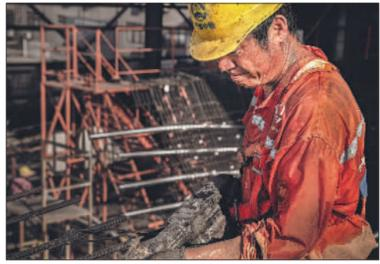
2021年8月21日,来自河北的白师傅在烈日下打磨混凝土箱梁凹凸不平的边角,汗水浸湿了全身。
