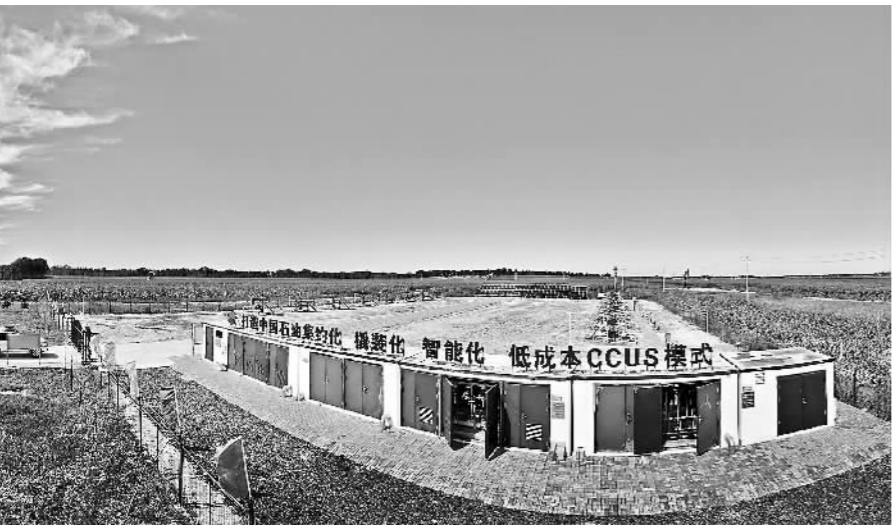
图为吉林油田黑125区块注气平台。
