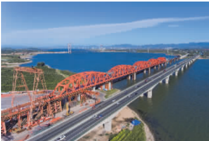
2017年8月23日,河北省怀来县官厅水库特大桥施工现场。
