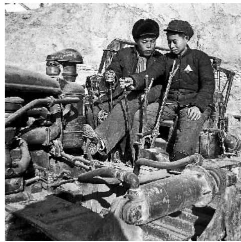
1954年,特等劳模郑福轩(左)在官厅水库工地教学员驾驶推土机。(工人日报资料图片)
