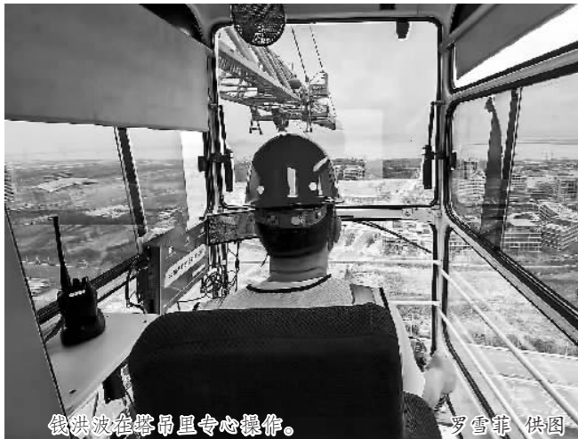
钱洪波在塔吊里专心操作。
