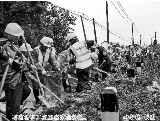
石岗岗冲工友正在清理淤泥。
