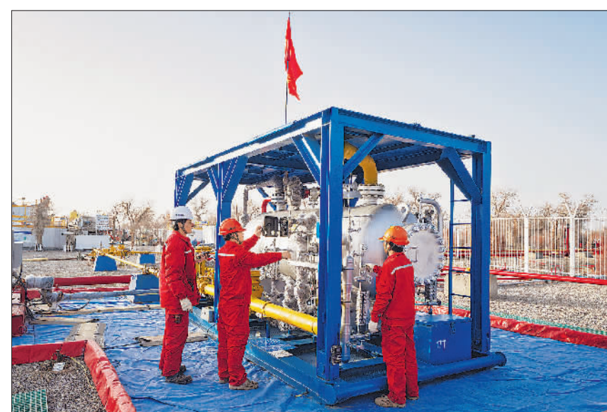
图为中国石化部署在塔里木盆地的“深地一号”跃进3-3XC井。该井完钻井深达9432米,刷新亚洲最深井斜深和超深层钻井水平位移两项纪录。新华社记者 马嘉帅 摄
