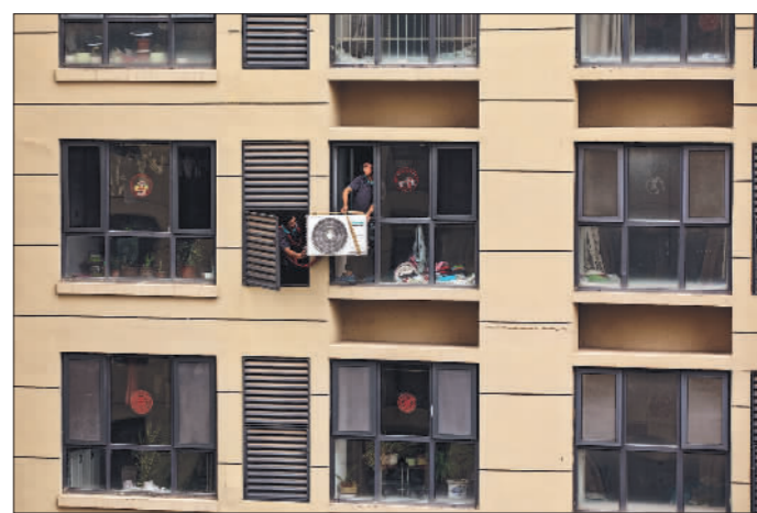
7月6日,空调安装工正在高层住宅楼上为客户安装空调。
