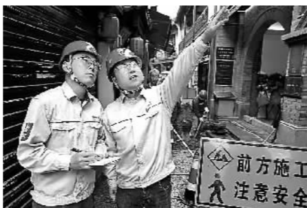
勘查进户走线和表箱安装位置(电网改造项目结合用户接电项目)。
