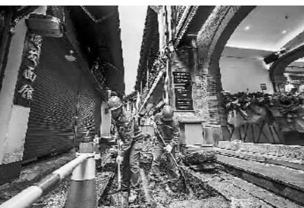
掀开古镇石板,清理敷设通道(江南第一茶楼门口)。
