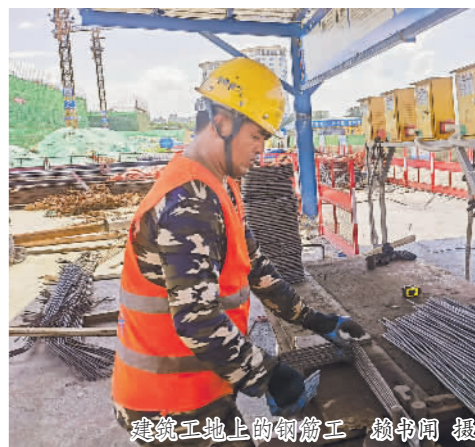
建筑工地上的钢筋工 赖书刚 摄
