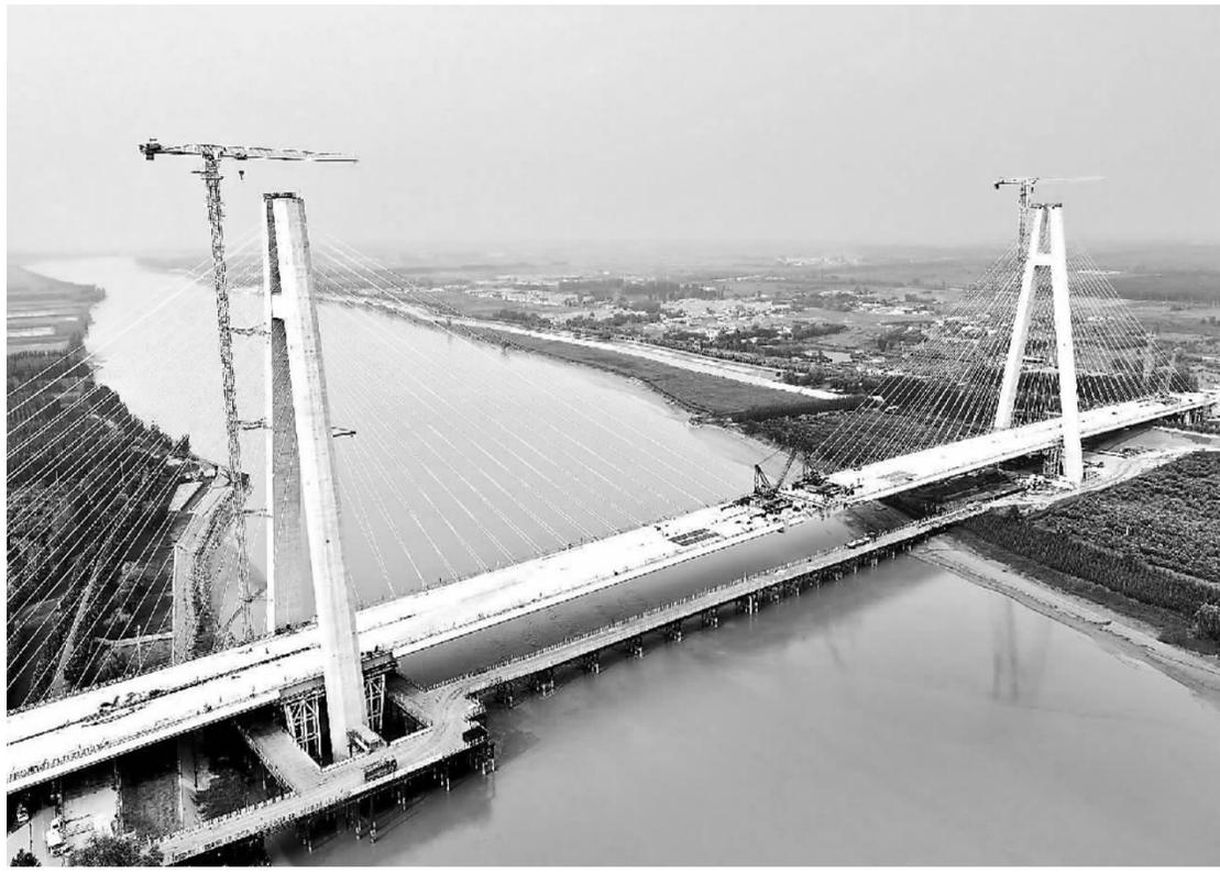
8月25日,山东东营,随着最后一块钢梁准确就位,黄河三角洲最大跨度A字型斜拉桥——天津黄河大桥顺利合龙。
