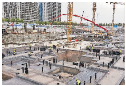
河北邢台时尚潮流港项目施工现场。
