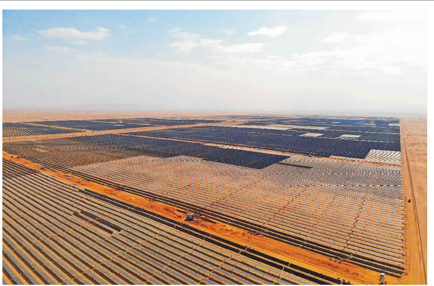
中企承建埃及500兆瓦光伏电站投入运营
