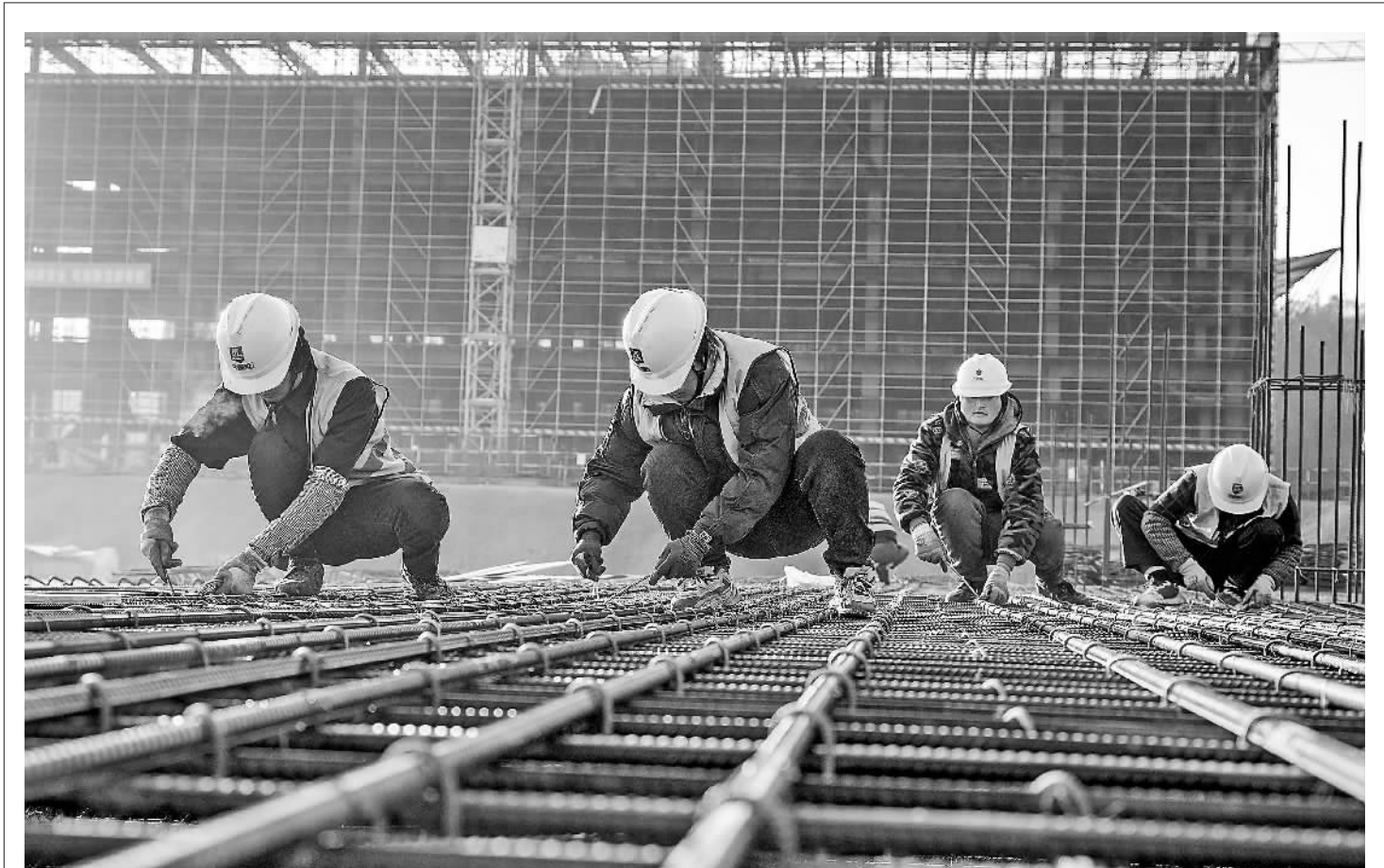
1月1日,建筑工人正在安徽省芜湖市繁昌区峨山镇的安徽农业大学创新港项目工地施工。新年伊始,各行各业的劳动者坚守岗位,铆足干劲,接续奋斗。
