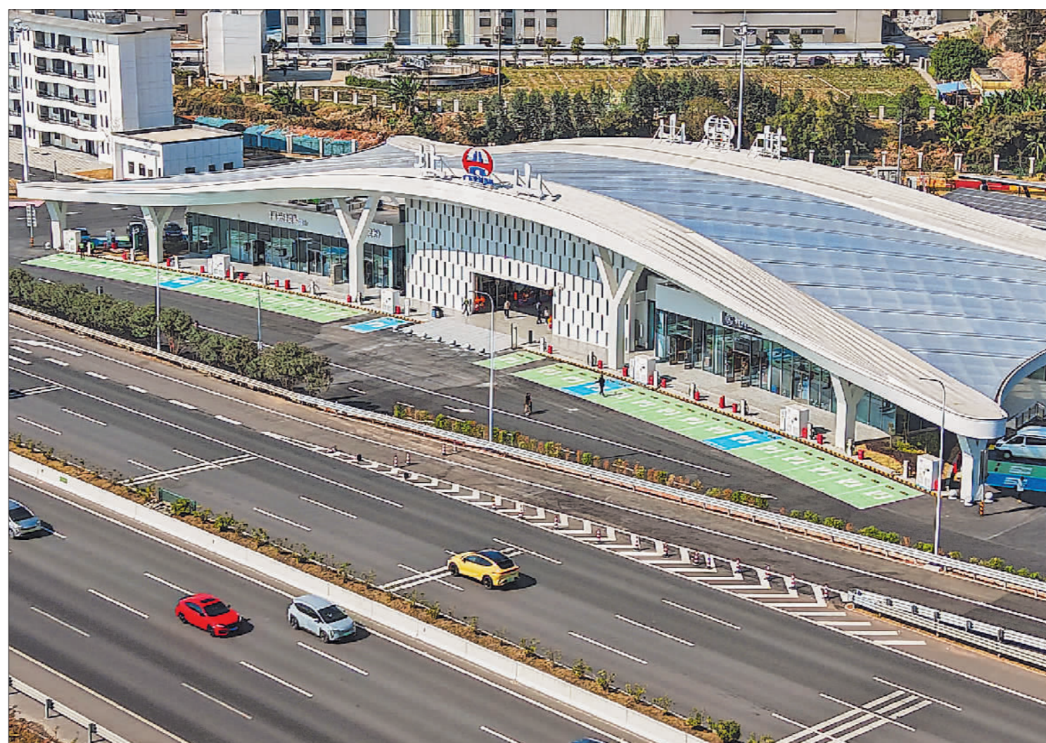
广东建成高速公路 新能源服务区
