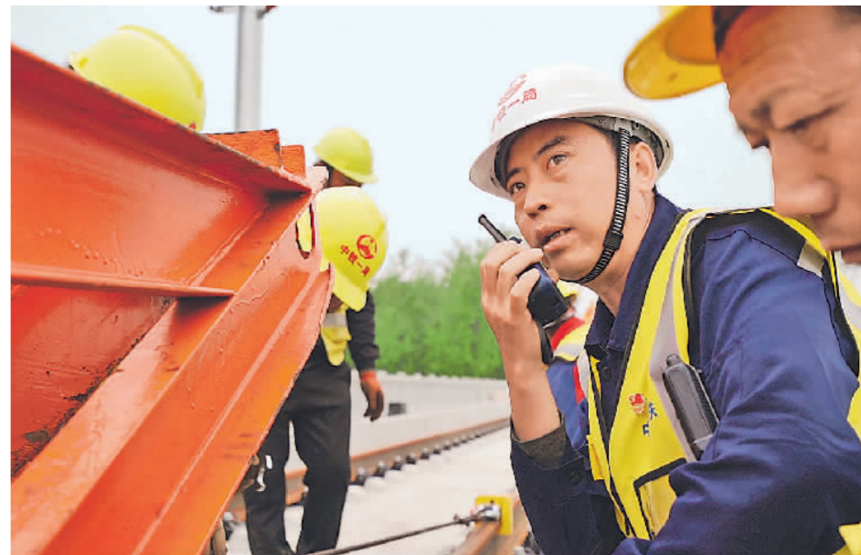
图为郝铎在指挥铺轨作业。
