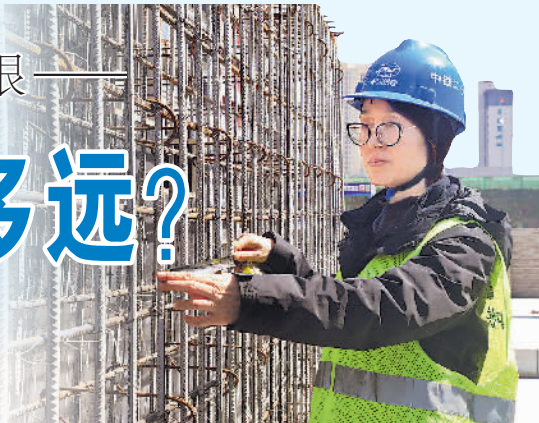
图为张烈霞在测量钢筋绑扎尺寸。 受访者供图
